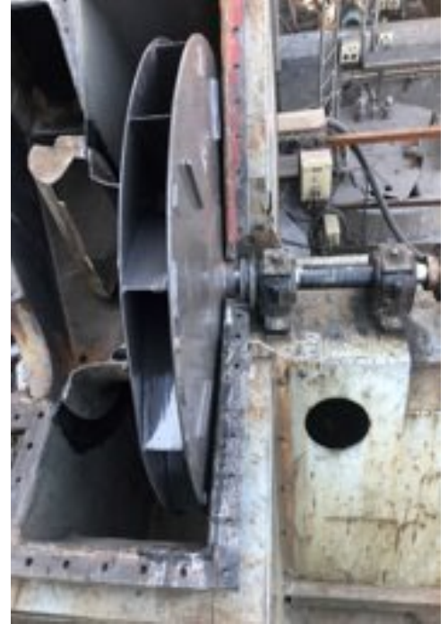
Petrochemical exhaust flue fan blades
